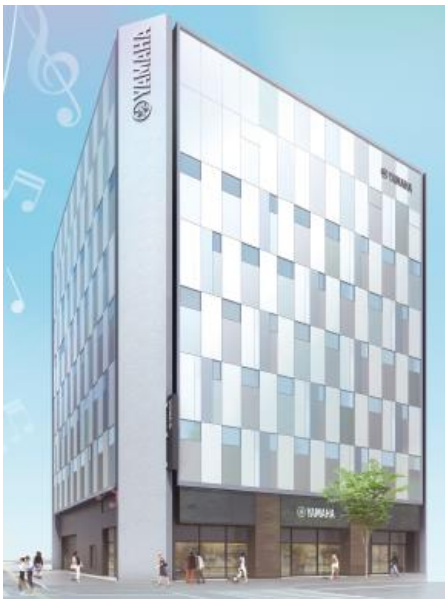
ヤマハ名古屋ビル外観イメージ
