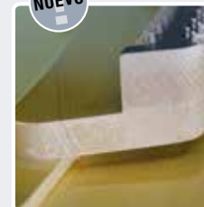
Puente en voladizo
